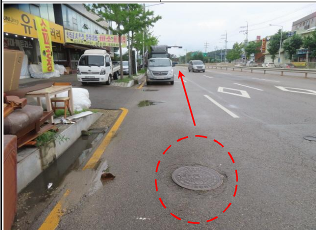
송수-2 (Sta.10+19.0) 4차선 도로 - 매송고색로
