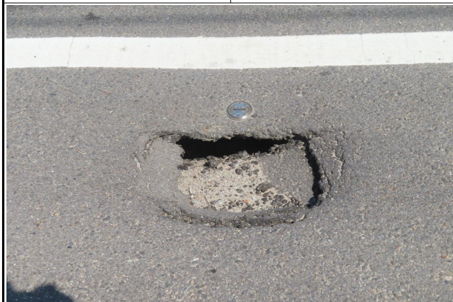
4구간 (Sta.40+00) 4차선도로 - 화성로
