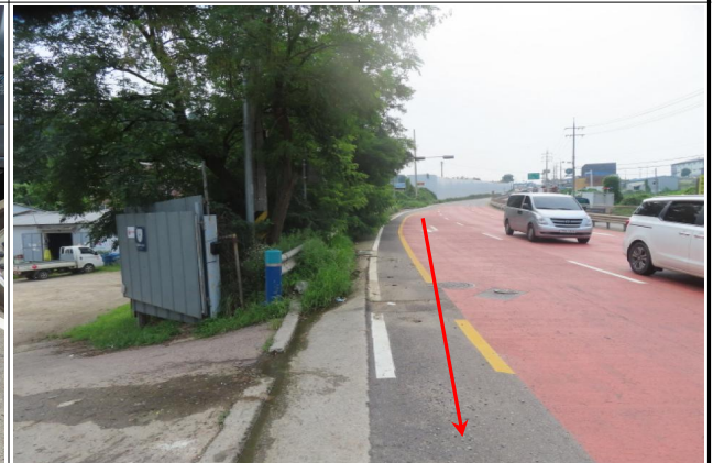
4구간 (Sta.79+01) 4차선도로 - 화성로
