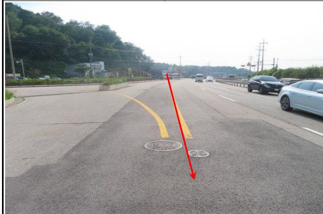
4구간 (Sta.97+08) 4차선도로 - 화성로
