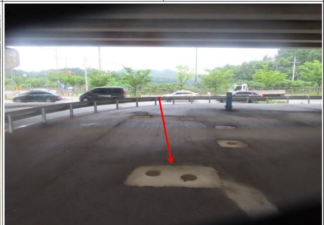
B-9구간 (Sta.358+0.0) 도로구간 - 수화교차로
