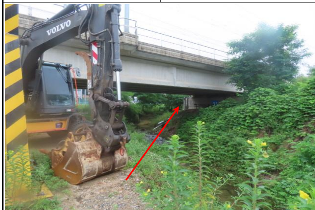
B-2구간 (Sta.13+0.0) 소하천
