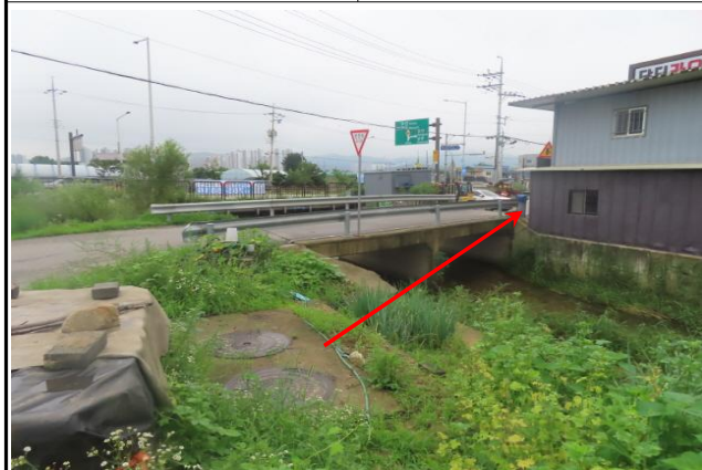
B-1구간 (Sta.0+30.0) 동화천
