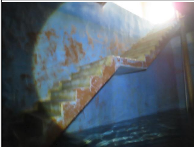
배수지 1지 안전난간 미설치
