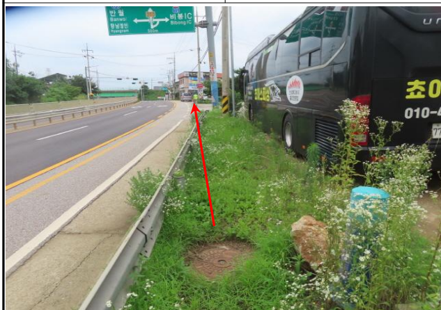
B-5구간 (Sta.124+0.0) 도로구간 - 화성로
