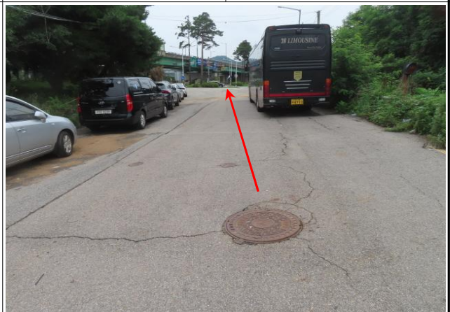
B-4구간 (Sta.91+0.0) 도로구간
