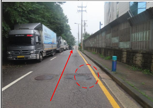
B-7구간 (Sta.173+0.0) 도로구간
