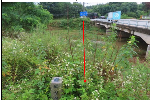
송수-2 (Sta.35+00.0) 하천 횡단구간
