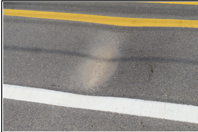
4구간 (Sta.40+00) 4차선도로 - 화성로
