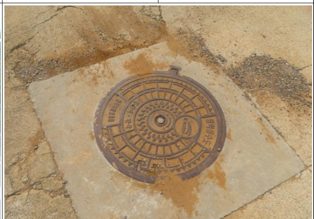
C-1구간 (Sta.15+0.0) 도로구간 - 남양서로620번길
