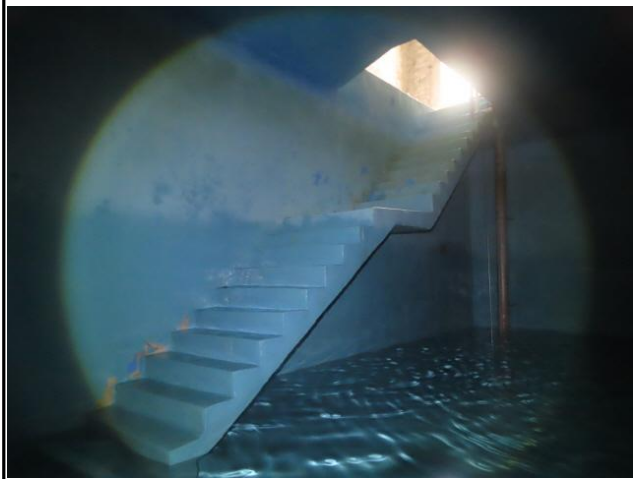
배수지 2지 안전난간 미설치
