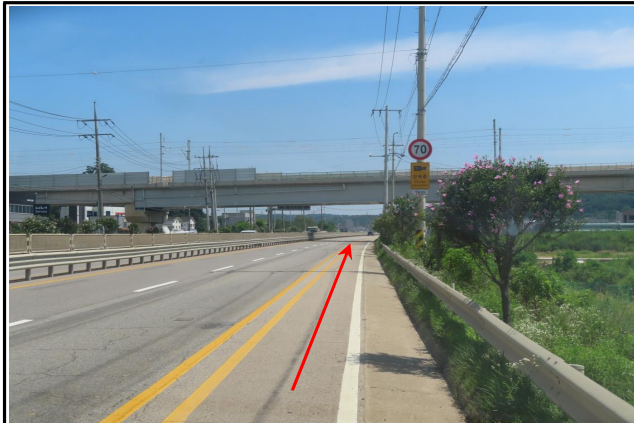
4구간 (Sta.36+35) 4차선도로 - 화성로
