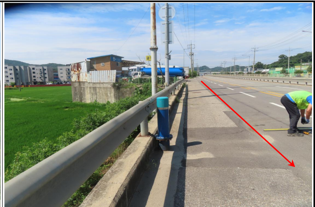
4구간 (Sta.37+35) 4차선도로 - 화성로
