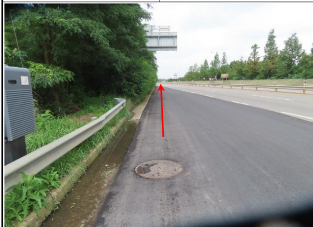
송수-4 (Sta.66+37.0) 4차선 도로 - 매송고색로
