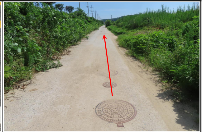
4구간 (Sta.52+08) 부체도로
