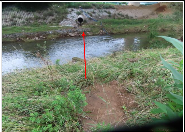
송수-3 (Sta.36+34.0) 하천 횡단구간 - 동화천
