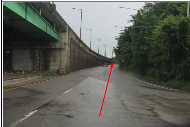
송수-4 (Sta.35+36.0) 램프구간
