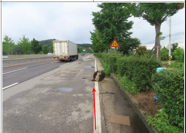
송수-5 (Sta.109+1.0) 4차선 도로 - 매송고색로
