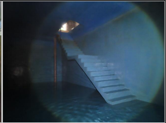
배수지 1지 안전난간 미설치
