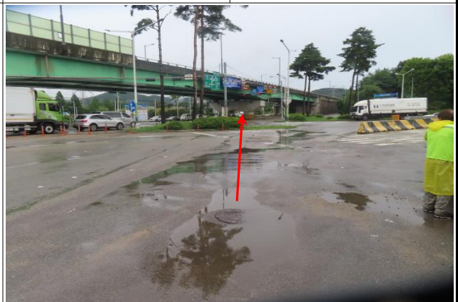
송수-3 (Sta.34+00.0) 이면도로
