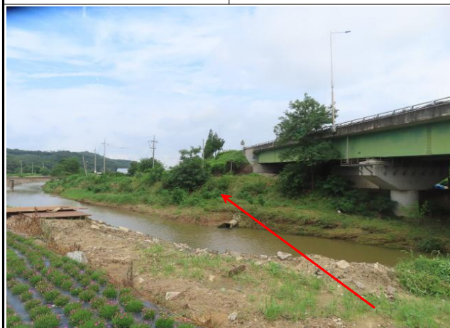
송수-5 (Sta.90+00.0) 하천 횡단구간 - 동화천
