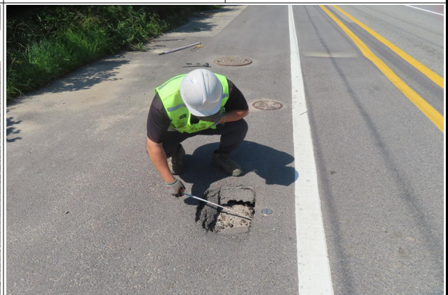
4구간 (Sta.40+00) 4차선도로 - 화성로
