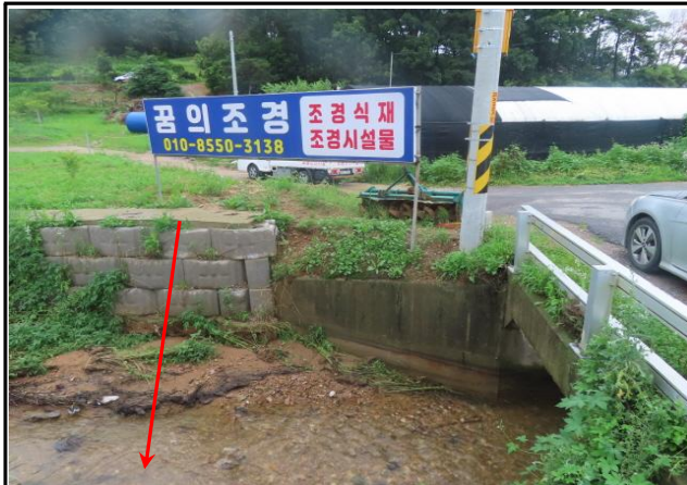
B-8구간 (Sta.298+3.0) 도로구간 - 남이로
