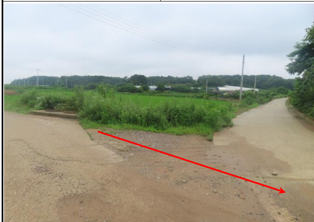
B-9구간 (Sta.344+3.0) 농로
