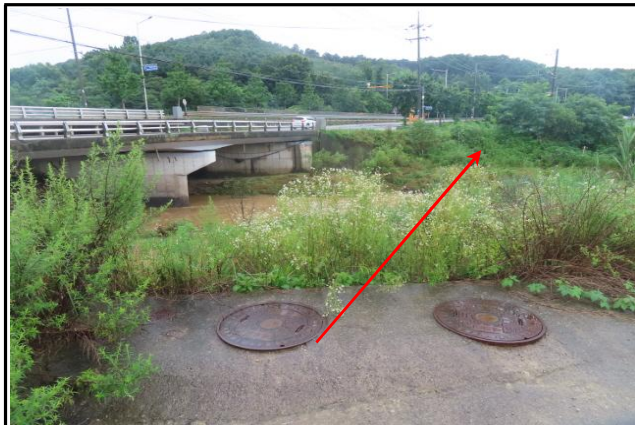
송수-1 (Sta.2+10.5) 하천 횡단구간
