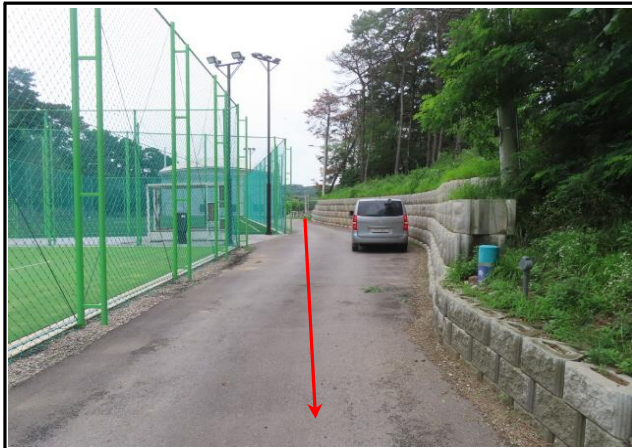
B-6구간 (Sta.163+0.0) 도로구간 - 폐도로
