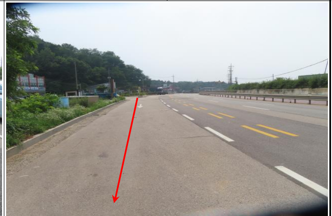
4구간 (Sta.104+03) 4차선도로 - 화성로
