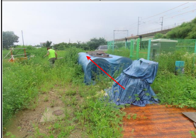
B-4구간 (Sta.79+0.0) 농로
