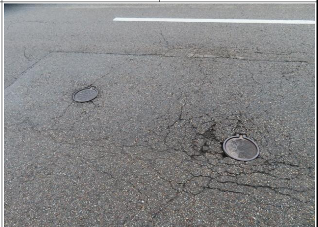
송수-2 (Sta.10+19.0) 4차선 도로 - 매송고색로
