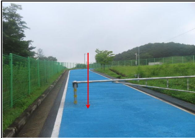
D-1구간 (Sta.5+00.0) 도로구간 - 남양서로620번길
