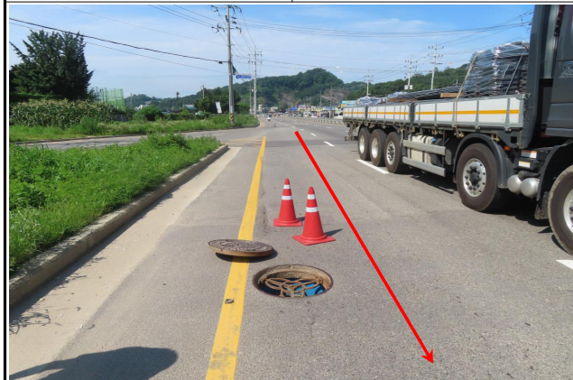
4구간 (Sta.67+10) 4차선도로 - 화성로
