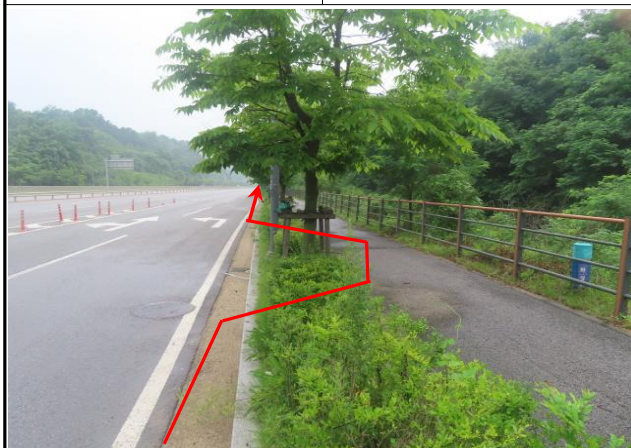
G-1구간 (Sta.6+30.0) 부체도로
